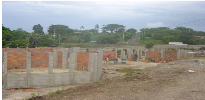
Die ersten Säulen stehen und der Bau geht zügig voran.
